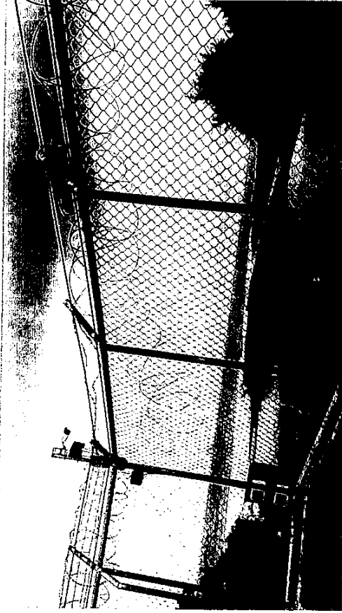
รายละเอียดภาพประกอบการตรวจรับในเขตการบิน (Airside) ประจำเดือน ส.ค.65 - ตรวจพบเห็นแหล่งหลบหนามเป็นสนิม, ฝู และเริ่มชำรุด บริเวณแนวรั้วทางวิ่ง 409 ฝั่งไม้ขาว จำนวน 1 จุด (ประมาณ 50 เมตร)
