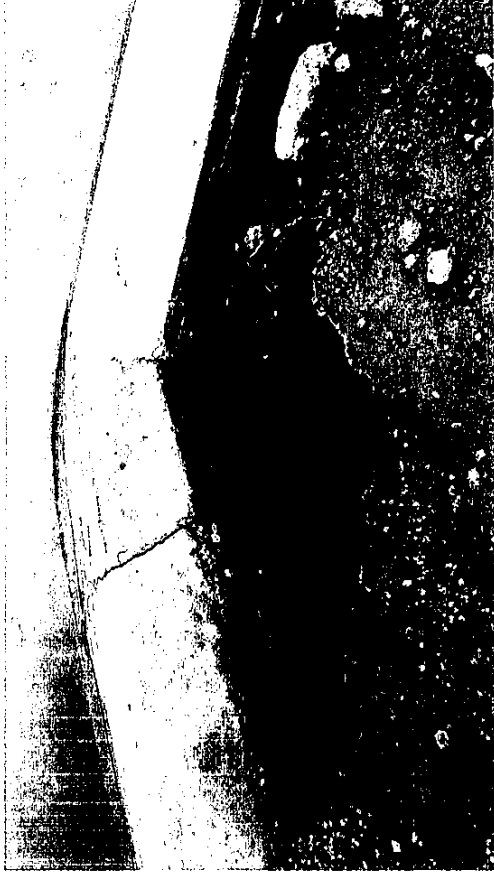
- ตรวจพบโครงคานหลุดตัว บริเวณรางน้ำสาย A (ติดรั้วฝั่งไม้ขาว) ใกล้หัวทางวิ่ง 09 จำนวน 1 จุด
